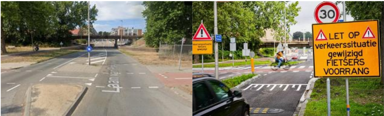
Figuur 5. Voorbeeld van verwachtingen bij de reconstructies van een solitaire fietsoversteek. Automobilisten waren gewend dat overstekende fietsers voorrang moesten verlenen (links). In gewijzigde situaties moeten automobilisten voorrang verlenen aan de overstekende fiets. Om het oude verwachtingspatroon te doorbreken heeft de wegbeheerder opvallende borden geplaatst en de rode fietsoversteek op een plateau gelegd. Verder is de maximumsnelheid verlaagd zodat automobilisten meer tijd hebben om de taak 'voorrang verlenen aan kruisende fietsers' te kunnen uitvoeren.
