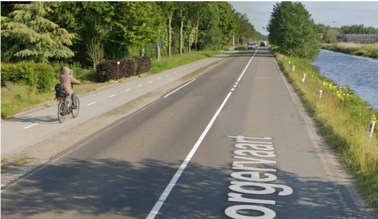
Figuur 6. Fietspad dicht naast N-weg waardoor fietsers bij duisternis verblind kunnen worden door koplampen van auto's (N373). Door het lawaai van de auto's op de hoofdrijbaan kan de fietser andere fietspadgebruikers minder goed horen aankomen. Google Maps, november 2023.
